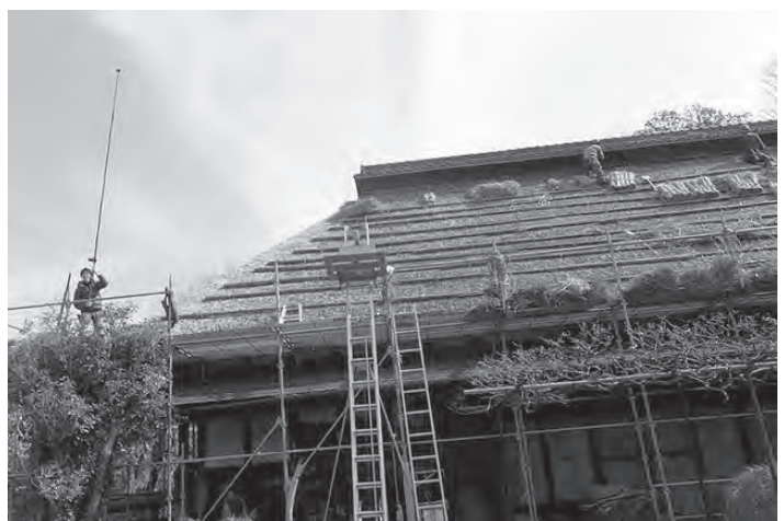
「飯田家住宅」の屋根の葺き替えを高所から撮影する伊藤さん(写真左、2019年2月)
